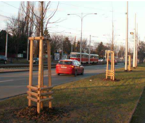
Výsadba a kotvení stromů (ul. Modřanská – Praha)
