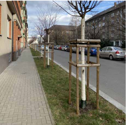
Kotvení a ochrana stromů (Ostrava - ul. Zborovská)
